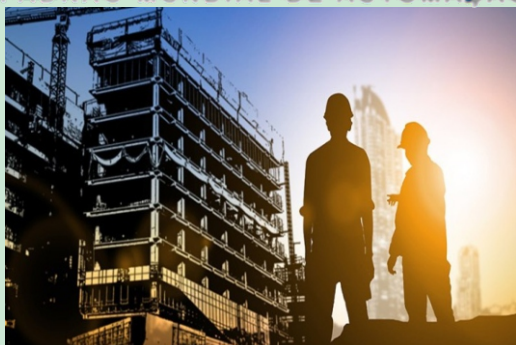
Construtoras e empreendimentos
